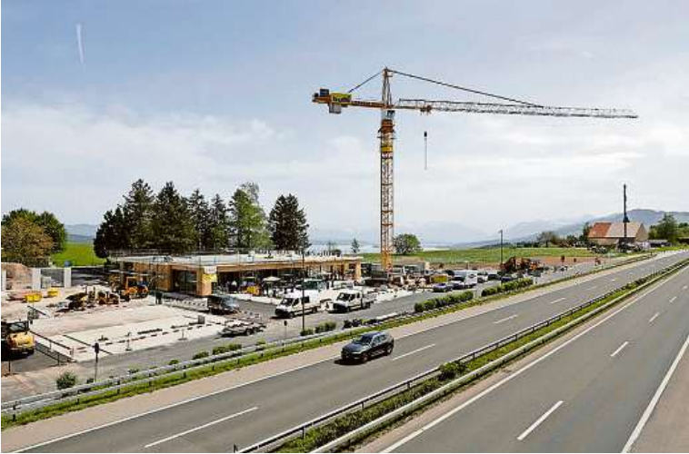
Eröffnung Anfang Oktober: Aktuell wird noch fleissig gebaut.
